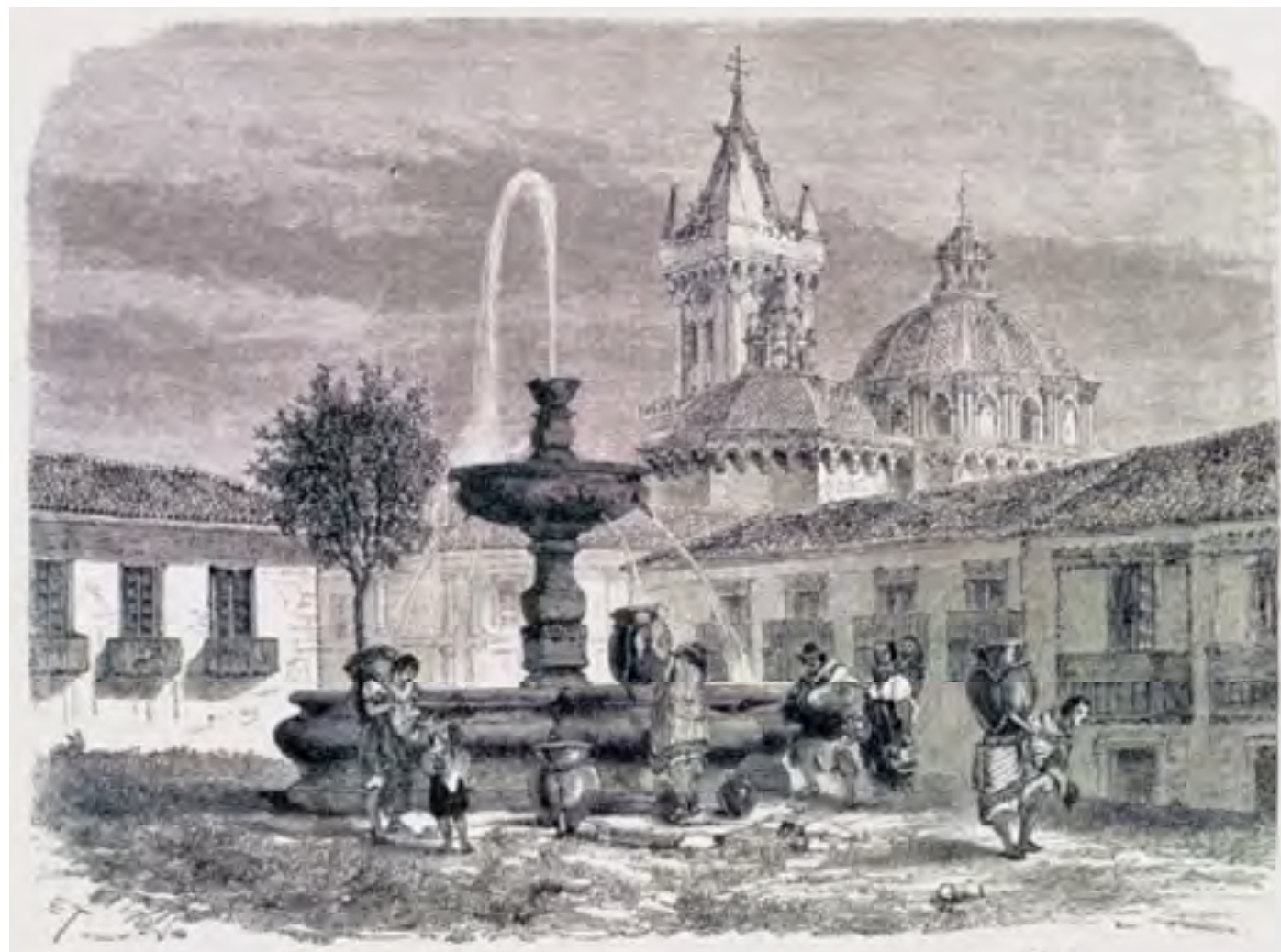
Pila de San Francisco, con las cúpulas de la Compañía al fondo, en Ernest Charton, "Quito, República del Ecuador".
