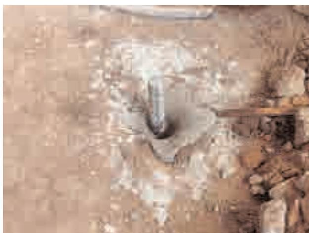
ellas. La asesoría estructural recomendó que este mortero sea utilizado en las perforaciones inclinadas, en la parte que se acerca al cielo de la bóveda, pero en el resto de su longitud, por el requerimiento de resistencia, que se use el mortero con cemento. Con esto se satisfacía tanto los aspectos de resistencia como los de cuidado del decorado de la bóveda.
