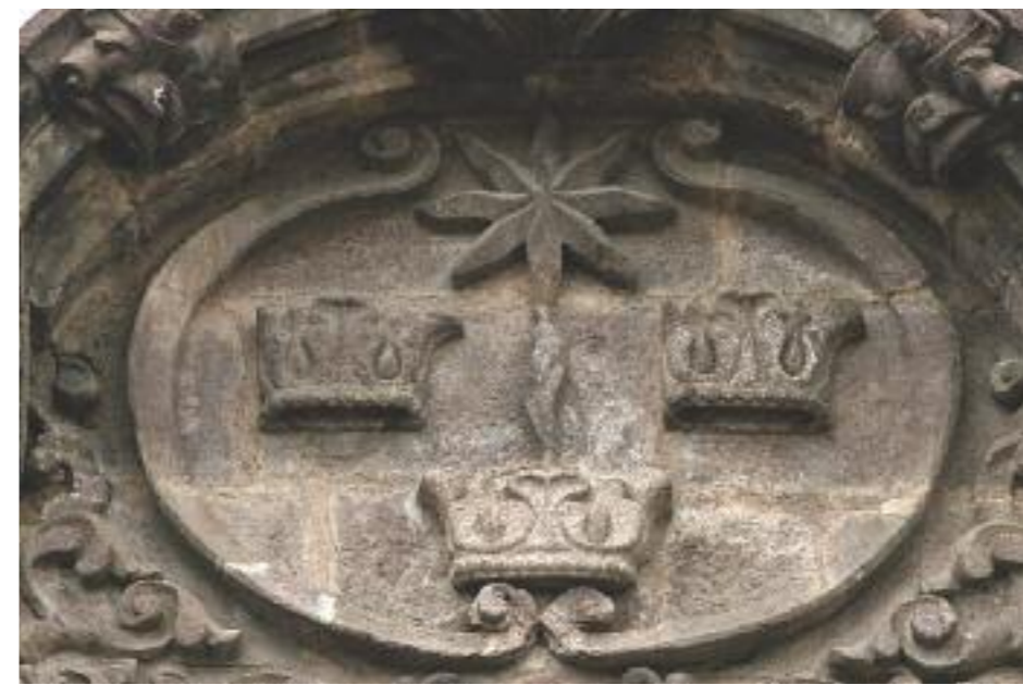
Detalles de la fachada de la iglesia del Hospital San Juan de Dios. FOTO: JORGE VINUEZA
