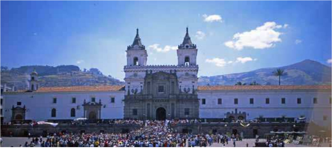
Lámina 3.1 Vista general, Iglesia y convento de San Francisco de Quito. Foto: Hernán L. Navarrete.
