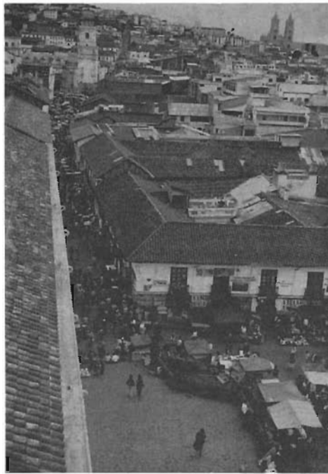
San Francisco. Cubierta del convento, atrio y Plaza.
